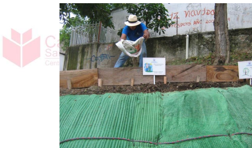
Figura 2. Instalación de manto en área piloto
